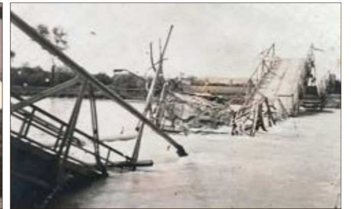
Die Reste der am 29. April 1945 von der Wehrmacht gesprengten Isarbrücke. Fotos: Hildegard Seeholzer
