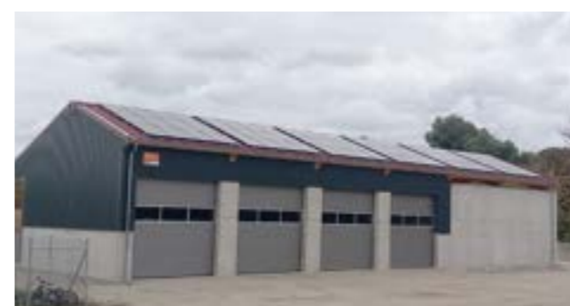
Einstellhalle bei der Kläranlage
