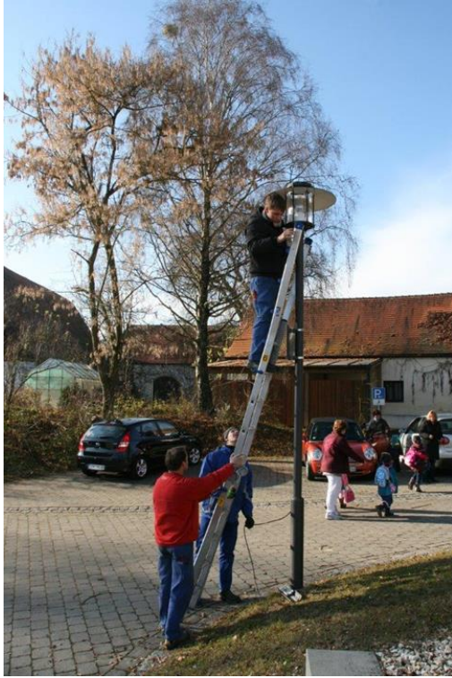
Abbildung 21: Umrüstung der Straßenbeleuchtung auf LED
